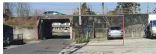
▲工事利用の車両通行で整備する道路
