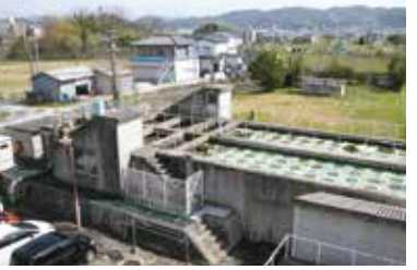
▲ 廃止予定の御所市櫛羅浄水場
