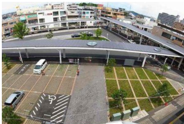
■ 駐車場 | 参考：北本駅西口駅前（埼玉県北本市）
