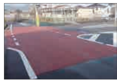
↑ 危険箇所の路面舗装
