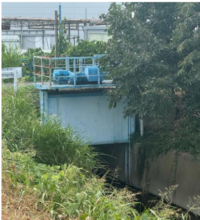
※既存の逆流防止樋門
