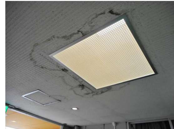
・ホール天井等改修
