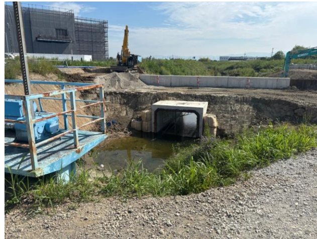
※2工区施工状況（下流側函渠の構築）
