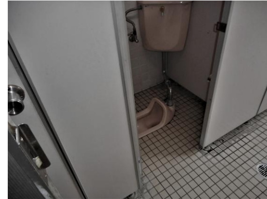
・職員用トイレを男女別に改修
