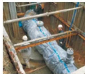
耐震管の布設
