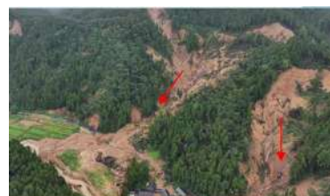
9月20日からの大雨（石川県輪島市）
