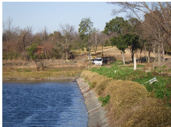
図7-5 外堤側の護岸に設置したフトンカゴと上部の植栽
