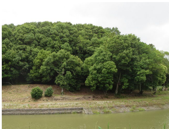
図10-1 フトンカゴによる護岸整備箇所が張タイプ（右側）から多段タイプ（左側）に変更された
