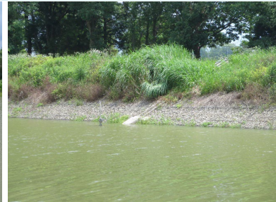
フトンカゴ (築堤側、中央に樋門)
