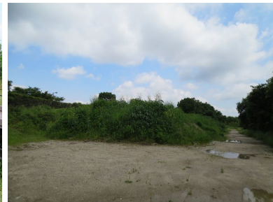
周濠浚渫土・築堤撤去土砂
