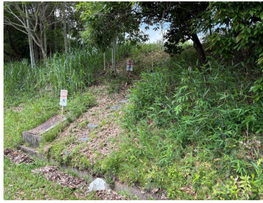
管理用通路(東側樋門付近)
