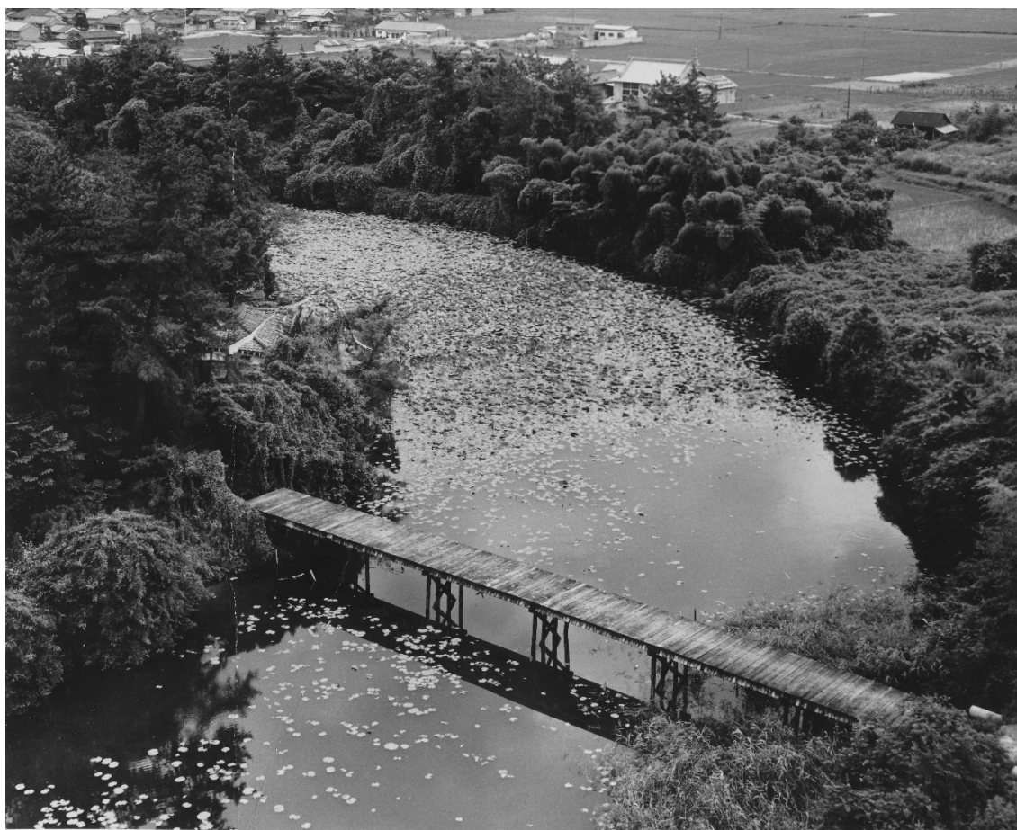
図3-22 現状変更時の橋。後円部には民家の屋根がみえる（昭和47年）
