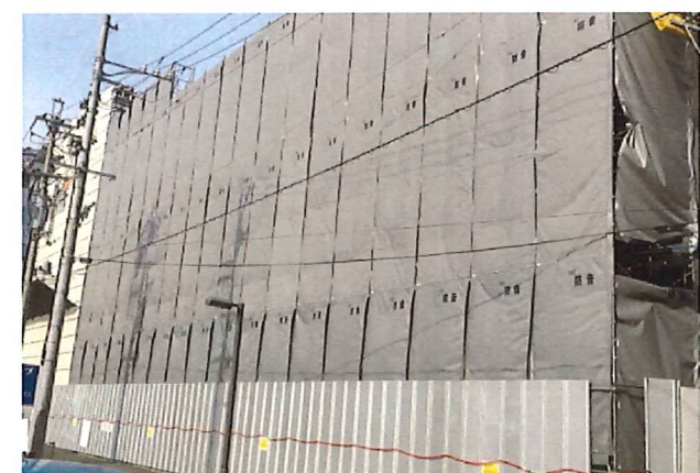
解体建物外周防音シート張り
