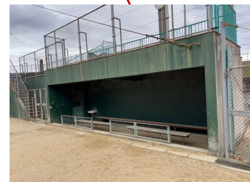
外野ベンチ更新 壁面塗装剥離修繕
