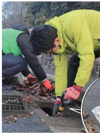
側溝に溜まった大量の落ち葉や泥をくみ上げます。このような側溝は、定期的な清掃ができないため、かなりの力仕事です。
