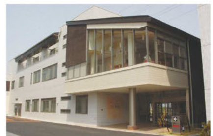
平成17年5月 奈良県初となるホスピス 「緩和ケアホーム飛鳥」開設
