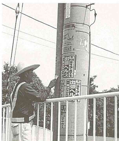
▲電柱などに張り付けられている違反広告物を、このように取り除いていただきます
