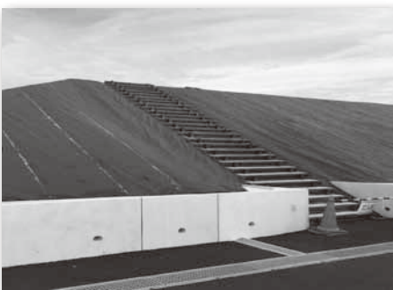
高架水槽の解体時に、杭が出てきたため、元に戻した。
