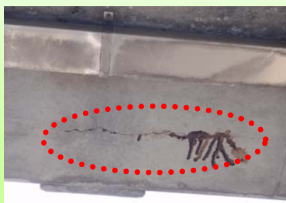
主桁の損傷（ひびわれ）
