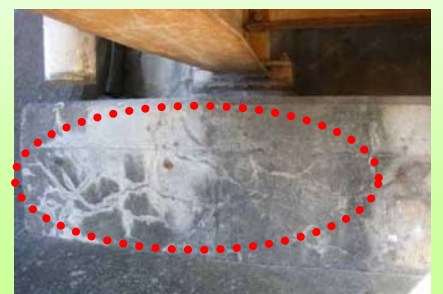
橋台の損傷（ひびわれ）
