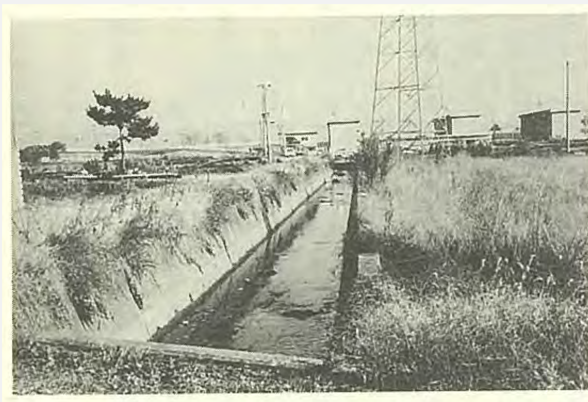
■古寺集落の南方に残る請堤
