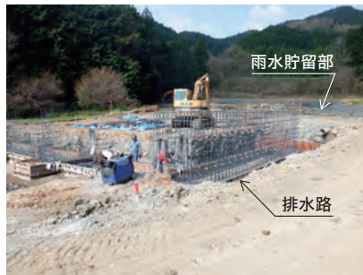
工事状況(今住流域貯留施設) (御所市)
