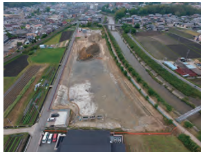
工事状況(葛下流域貯留施設) (王寺町)
