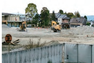
箆尾準工業地区造成工事
