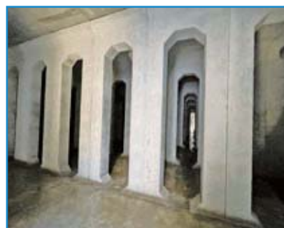
雨水貯留施設 内部
