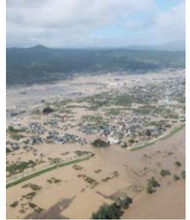
令和元年東日本台風による浸水被害 (長野市穂保地先)
