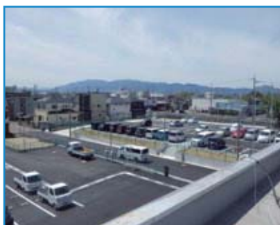
雨水貯留施設 外観
