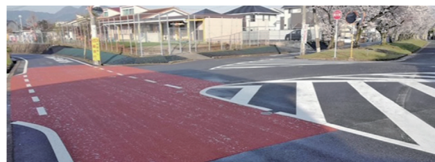
↑危険箇所の路面舗装
