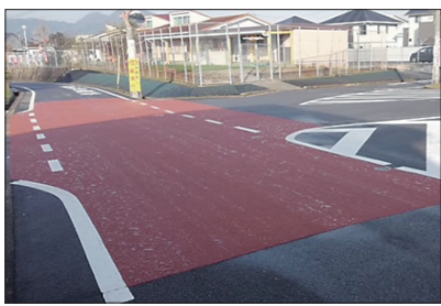
↑ 危険箇所の路面舗装
