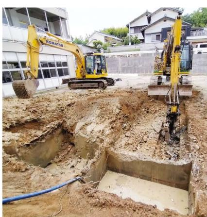
▲コンクリート圧碎機による浄化槽の解体工事
