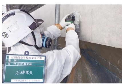
▲集塵装置付きグラインダーによる石綿含有塗膜除去工事
