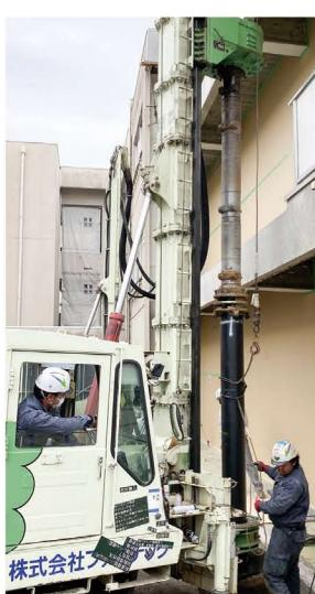
▲回転圧入式の低騒音型油圧式杭打機による钢管杭の施工
