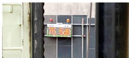
▲校舎廊下に設置した騒音測定機により10分間の平均値が基準を越えないよう管理
