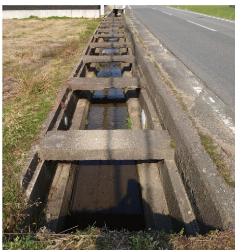
▲町道南22号線西側水路
