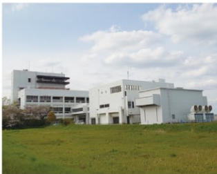
▲奈良県第二浄化センター
