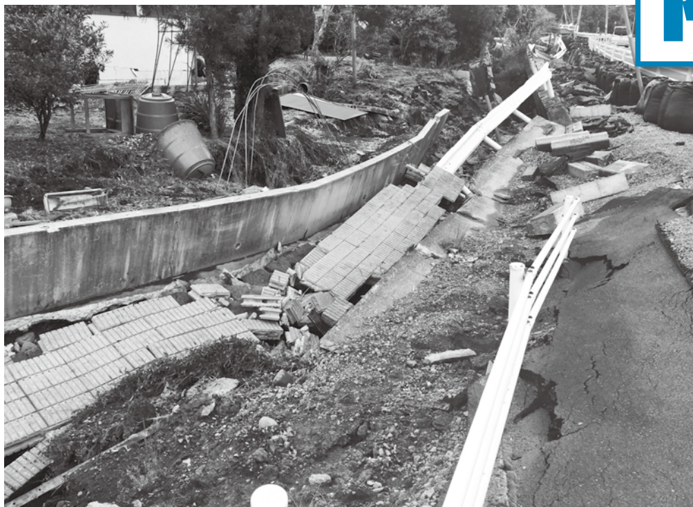
▲道路の崩壊（熊本県益城町）
