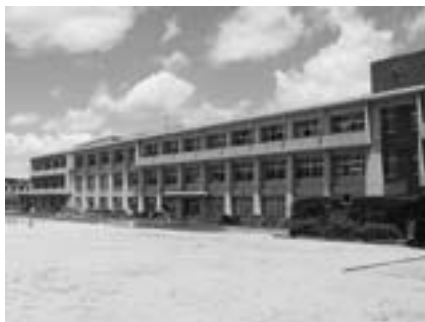
校舎改修工事が行われる真美ヶ丘第一小学校
